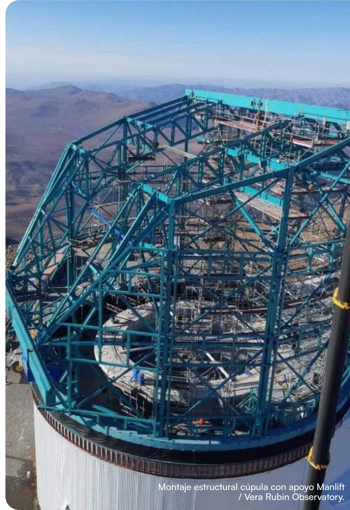
Montaje estructural cúpula con apoyo Manlift / Vera Rubin Observatory.
